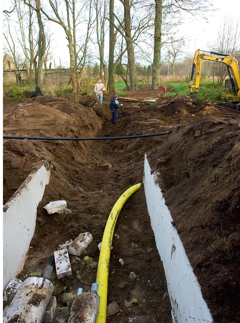
**MAAKÜTTEKS paigaldatakse maa alla keskmiselt 1 km pikkune musta värvi PEM-toru, mis on sama vastupidav kui klaas - 10 000 aastat.** FOTO:
