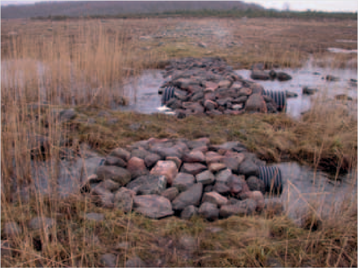
Foto 6.2.3. Paigaldatud truubid ajaloolises munakivitammis. (Foto K. Lotman)
