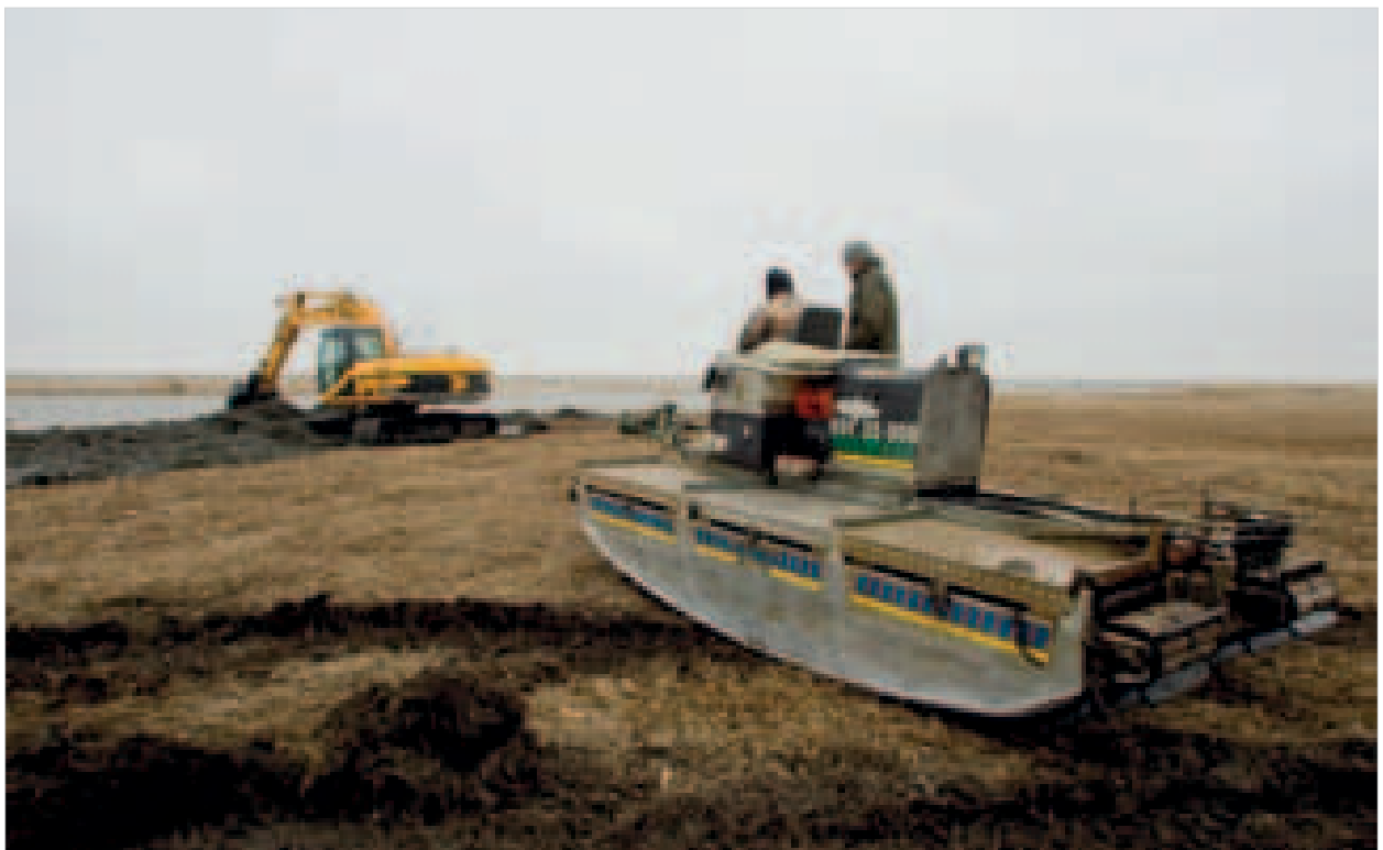
Foto 6.1.6. Lõugastest eemaldatud setete ja taimeosade laotamine kallastele (tagaplaanil). Esiplaanil Truxor amfibitraktor
