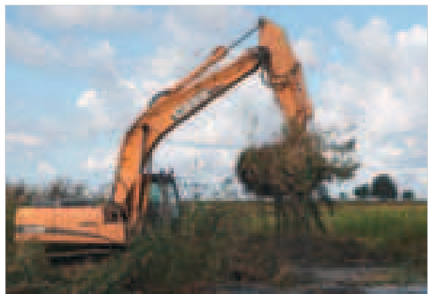
Foto 6.1.8. Pilliroog ja selle paksu risoomistiku eemaldamine ekskavaatoriga Võiste suure lõuka põhjakaldalt 2009. aastal
