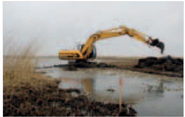
Foto 6.1.5. Rannikulõuka merega ühenduskanali taastamine ekskavaatoriga
