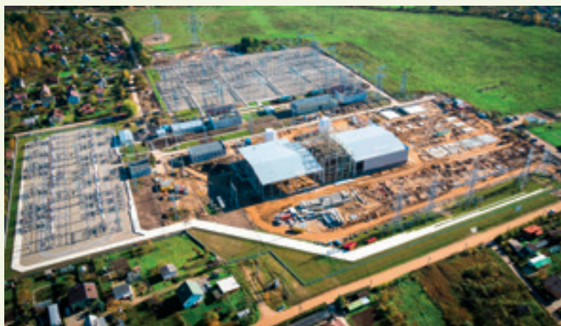
Foto 3. NordBalt konverterjaam Klaipėdas (Leedu)
