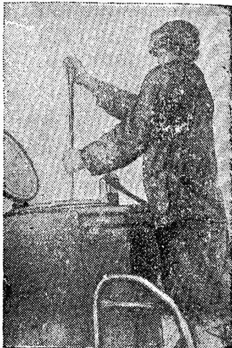
Рис. 33. Шуровка чурок в бункере газогенератора.
