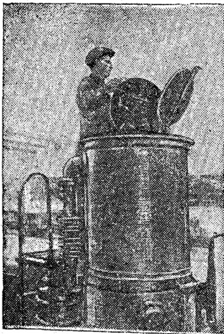
Рис. 32. Загрузка чурок в бункер газогенератора.
