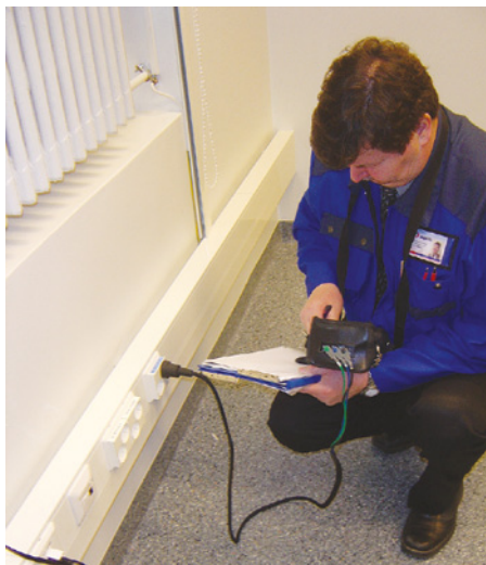
Joonis 1.4. Tehniline kontroll tuleb teostada igas elektripaigaldises enne selle kasutusele võttu
