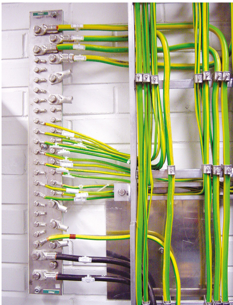
Joonis 4.7 Potentsiaaliühtlustuses ühendatakse kõrvalised juhtivad osad pingeltide juhtivate osadega
