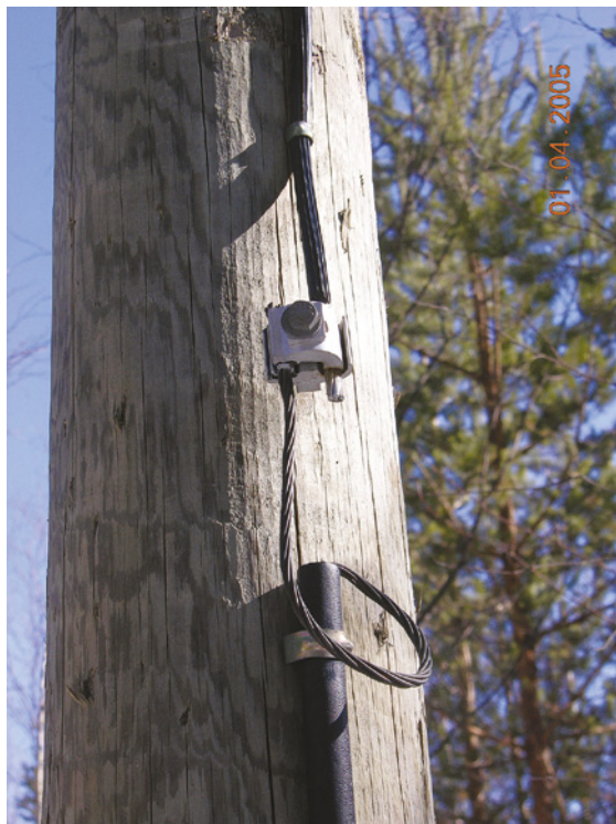
Joonis 4.4 Maandusjuhti tuleb kaitsta juhul, kui seda on võimalik mehaaniliselt vigastada
