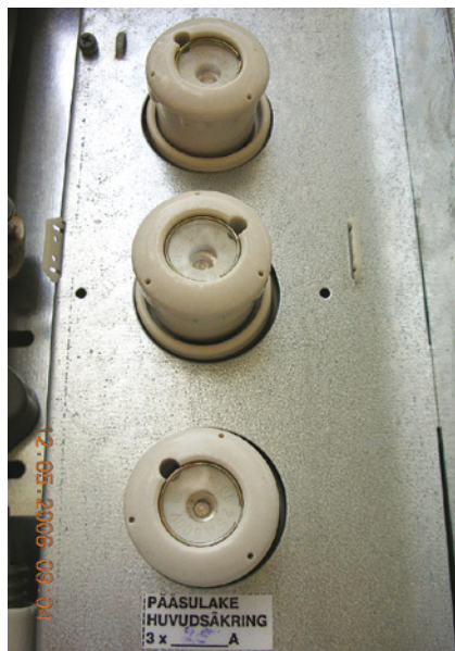
Joonis 5.3 Üldjuhul kasutatakse sulavkaitsmeid endiselt peakaitsmetena
