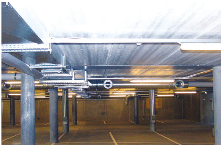
Joonis 4.8 Kõrvalisteks juhtivateks osadeks on näiteks metalltorud ja kanalid
