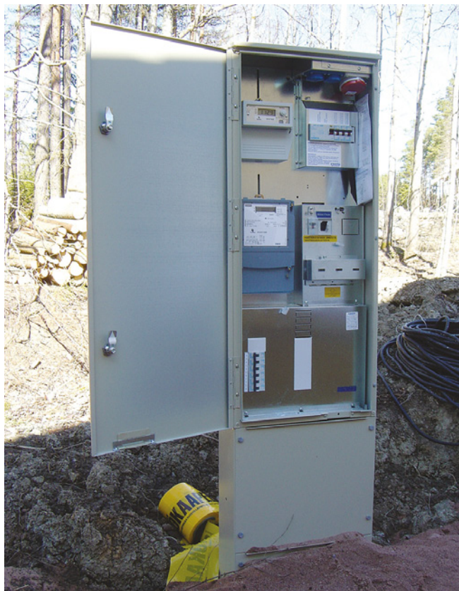
Joonis 2.14 Jaotusvõrguettevõtte on märkinud lühisvoolu suuruse liitumispunktis
