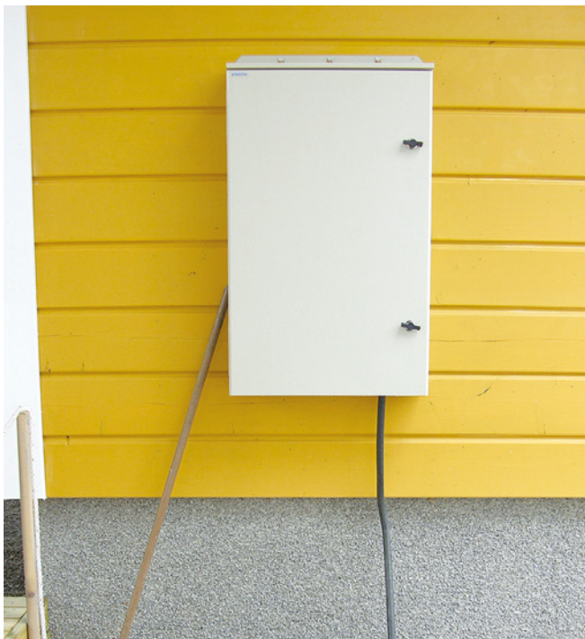
Joonis 2.18 Peakilp hoone välisseinal
