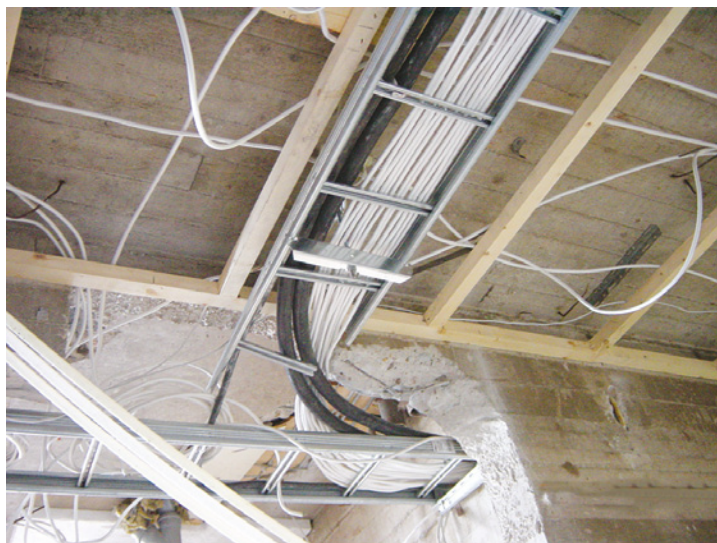
Joonis 7.1 Alumiiniumist kaabliredelite (-rennid) eeliseks on muuhulgas vähene kaal
