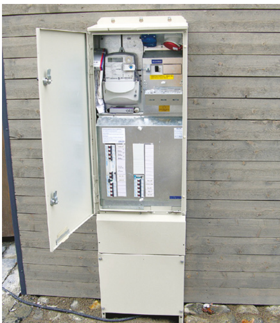
Joonis 2.9 Krundile paigaldatud kilpe kasutatakse üha enam eramute peakilpidena.
