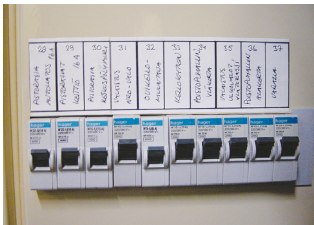
Joonis 5.1 Liinikaitselülitid on lõppvooluahelate kaitses sulavkaitsmed välja tõrjunud
