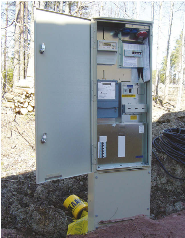
Joonis 2.17 Peakilbi ülesannet täidab krundi liitumiskilp
