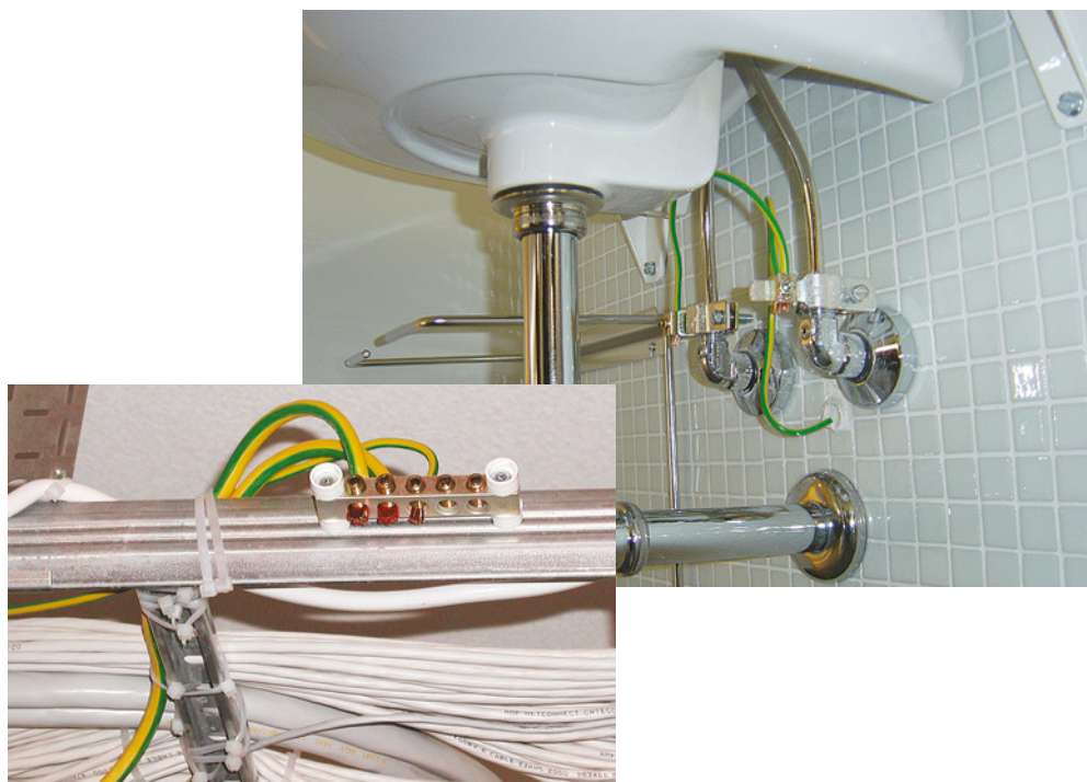
Joonis 4.11 Erinevail põhjustel tehtud potentsiaaliühtlustusi
