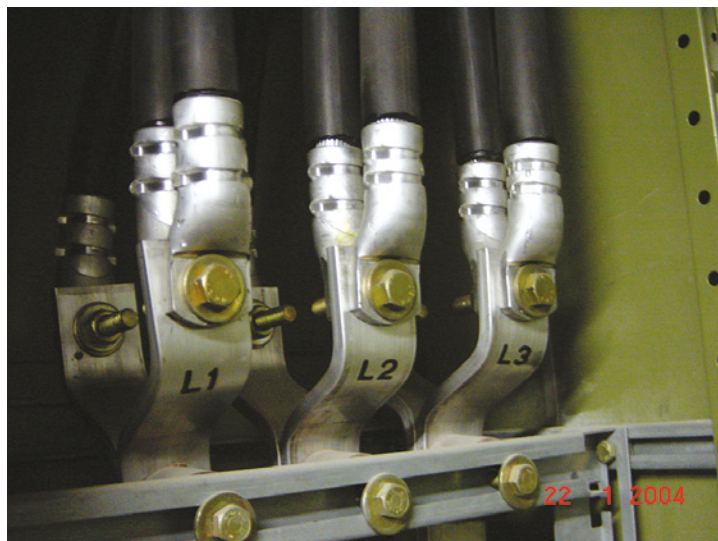
Joonis 8.2 Press- ja poltliited
