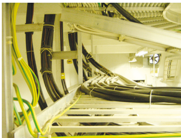
Joonis 6.3 Kaabli pinnale kogunev tolm tuleb vajadusel eemaldada
